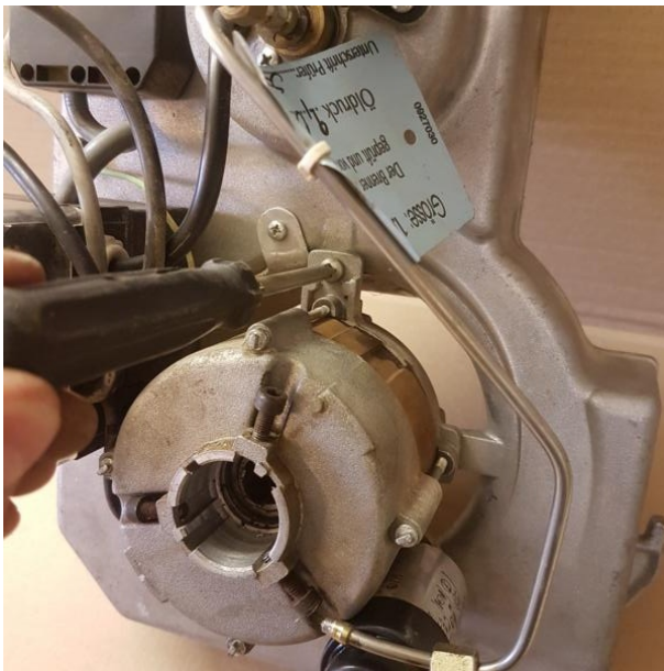
Der Ölbrennermotor wird demontiert.
