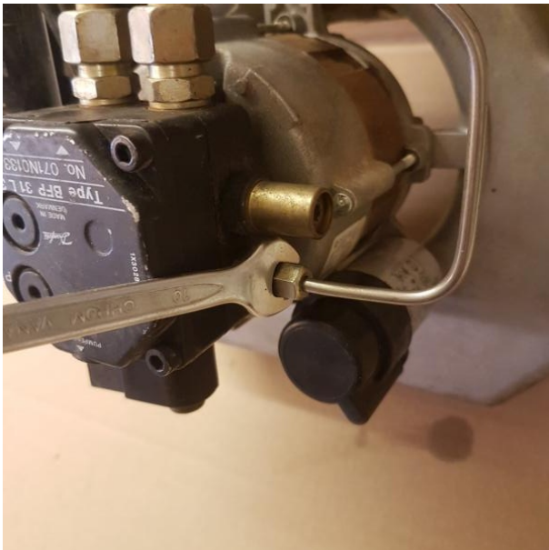
Die Ölleitung wird mit dem 10-mm-Maulschlüssel gelöst.
