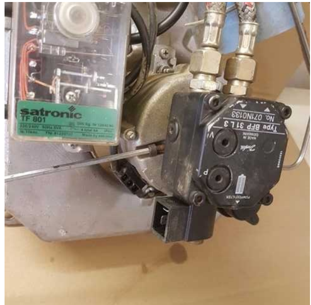
Die Ölpumpe wird mit dem Inbusschlüssel abgebaut.
