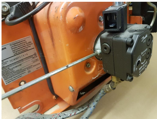
Die Ölpumpe wird abgeschraubt.
