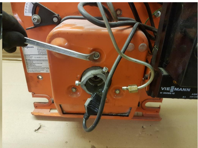
Der Brennermotor wird ausgebaut.
